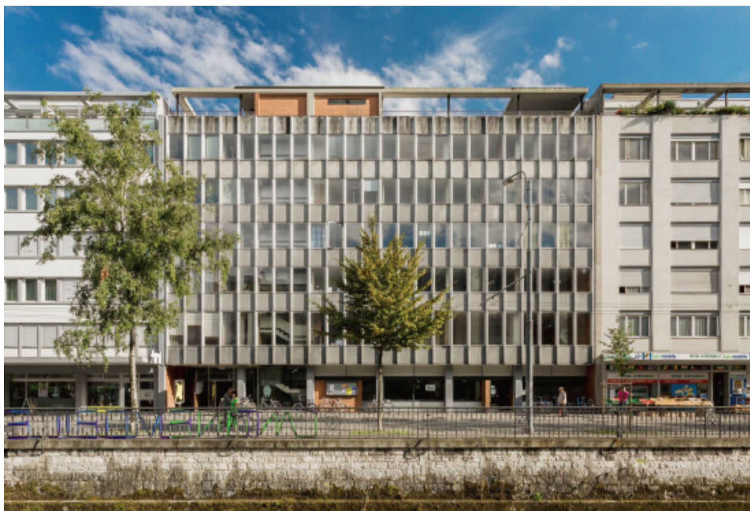
Das Farel-Haus am Oberen Quai muss saniert werden. Die Kirchgemeinde kann die Kosten nicht tragen und trennt sich von ihm. Jonathan Liechti/a
